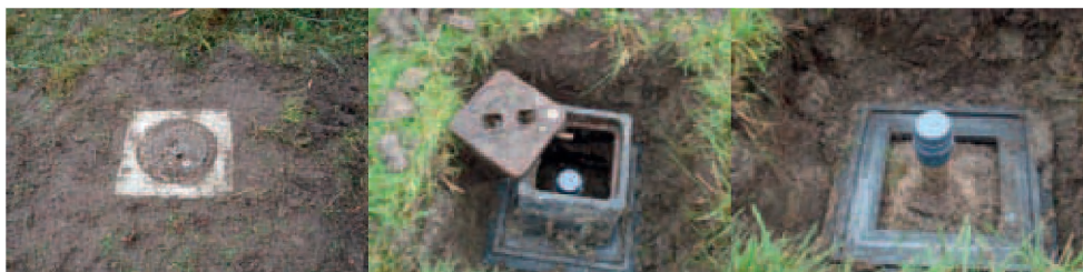
FIGUUR 3.4 ONDERTEGEL (MIDDEN EN RECHTS) EN BOVENTEGEL (LINKS) BIJ EEN STRAATPOT (BRON: PROVINCIE FRYSLÂN)
