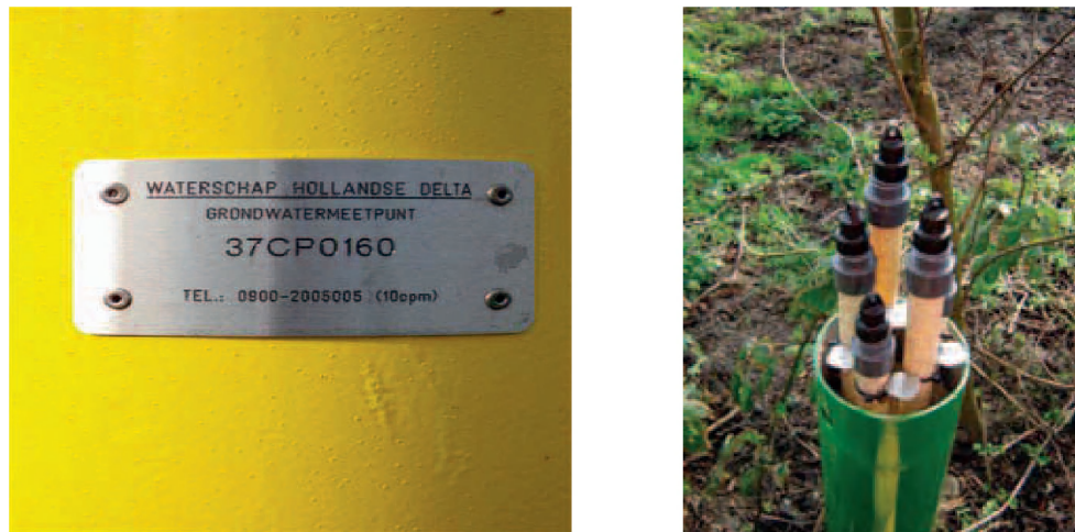
FIGUUR 3.6 GENUMMERDE PEILBUIZEN EN LABEL OP SCHUTKOKER (BRON: WILLEMSSEN, J., WATERSCHAP HOLLANDSE DELTA).
