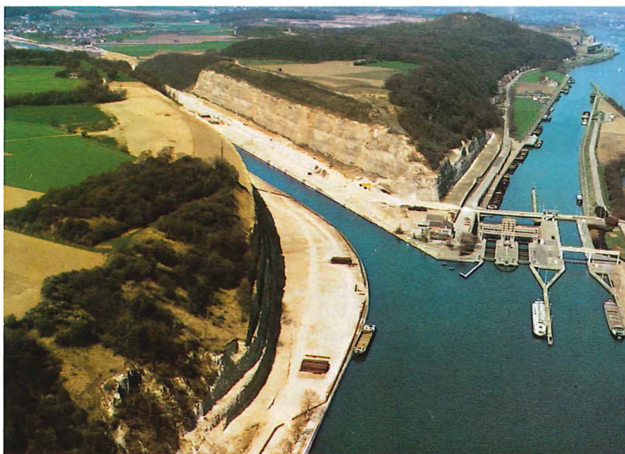
Fig. 13 Élargissement de la tranchée de Caster en cours d'exécution et canal de raccordement à la Meuse avec les trois écluses existantes. (deux écluses de 55×7,5 m et une écluse de 136×16 m). Verbreding van de uitgraving van Caster in uitvoering, en verbindingskanaal met de Maas met de drie bestaande sluizen. (twee sluizen van 55×7,5 m en een sluis van 136×16 m). Widening of the Caster trench in course of execution and connection canal with the Meuse River; three existing locks. (two locks of 55×7,5 m and one lock of 136×16 m).
