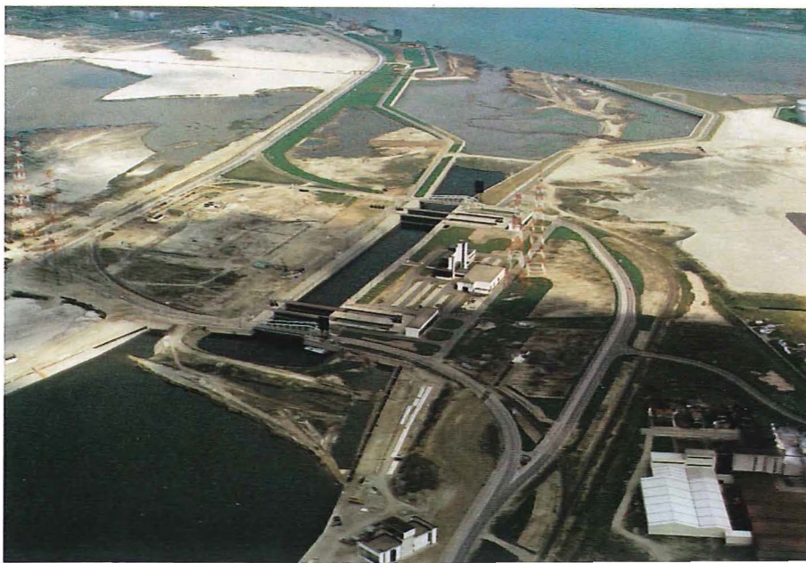
Fig. 9 Écluse de Kallo et ses accès en cours d'exécution. Sluis van Kallo met de toegangen in aanbouw. Kallo lock with its accesses in course of construction.
