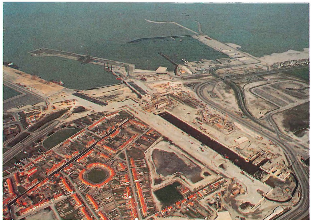
Fig. 3 Ecluse et avant-port en construction. Sluis en voorhaven in aanbouw. Lock and foreport in course of construction.
