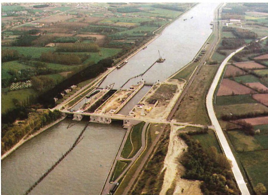
Fig. 14 Écluses d'Herentals. Deux écluses existantes de 136×16 m et nouvelle écluse de 200×24 m. Sluizen van Herentals. Twee bestaande sluizen van 136×16 m en een nieuwe sluis van 200×24 m. Locks at Herentals. Two existing locks of 136×16 m and a new lock of 200×24 m.
