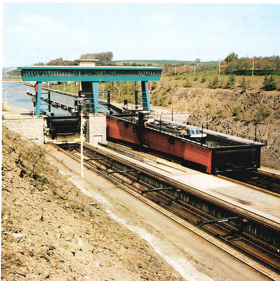
Fig. 18 Le bac et la tête aval. De bak en het benedenhoofd. The ferry and the downstream head.
