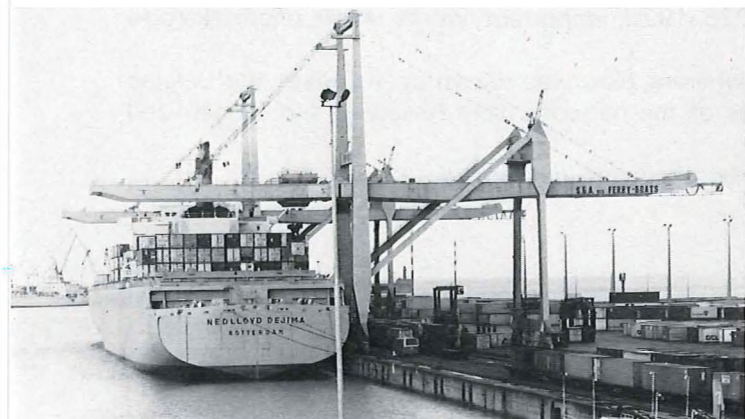
Fig. 11 Portique pour containers. Containerkranen. Gantry crane for containers.
