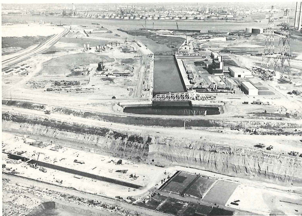
Zicht op de Kallosluis, met op de voorgrond de werken aan te tunnels (in open bouw)
