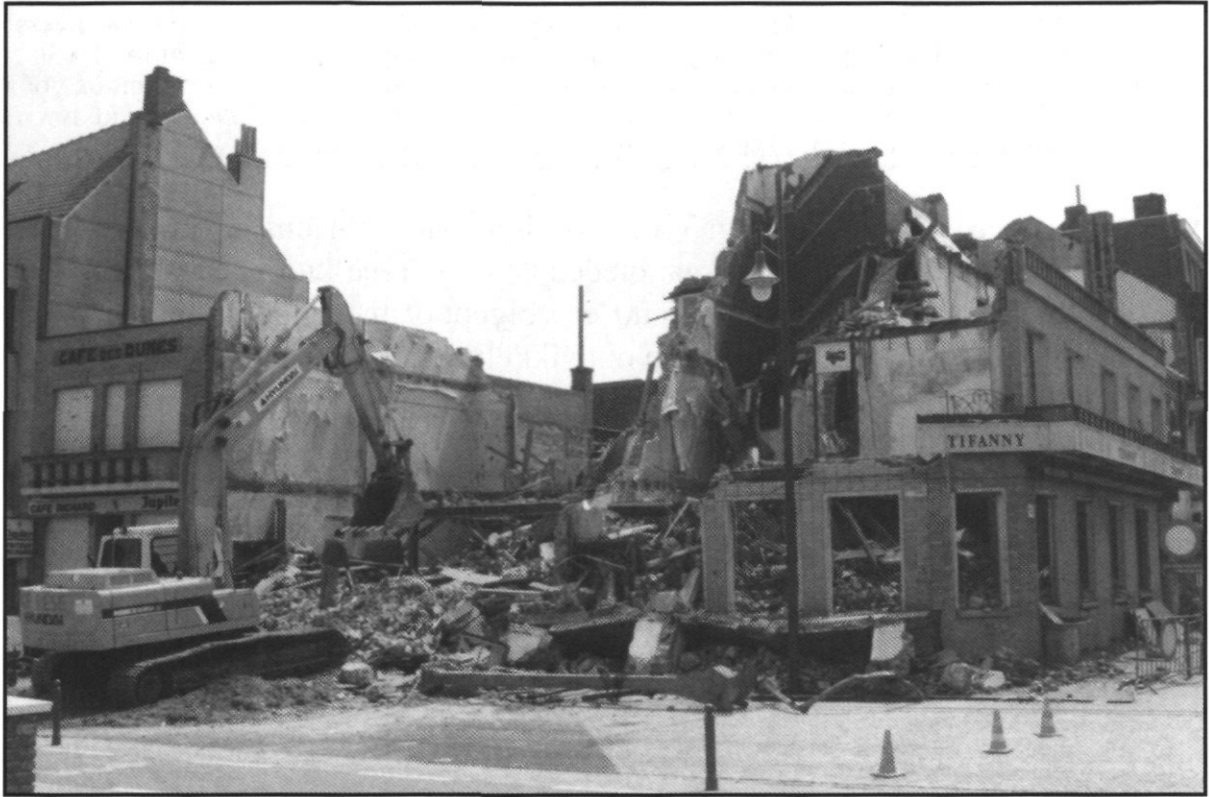
AFB. 26. DE AFBRAAK VAN DE 'COSMO' IN FEBRUARI 1998 EN DE AFBRAAK VAN HOTEL 'HELVETIA' EN DE GEWEZEN PATISSERIE VAN PLOVIE IN JUNI VAN HETZELFDE JAAR WAS HET BEGIN VAN EEN GROOTSE VERNIEUWINGSDRANG IN DE KAPELLESTRAAT. ONDERTUSSEN VERREES HIER RESIDENTIE 'HELVETIA'.
