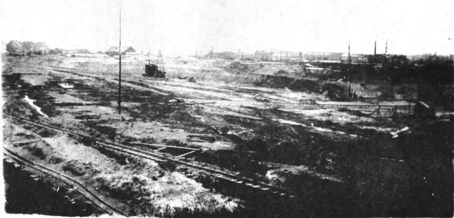
Fig. 1 - 1922 - Uitgraven van de vlotdok ( Foto Fr.Verbanck)
