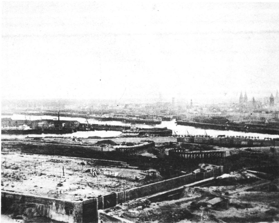
Fig.2.- 1926 - Bouw van de toegangssluis. Deze werd naderhand afgekeurd en vervangen door de huidige sluis.
