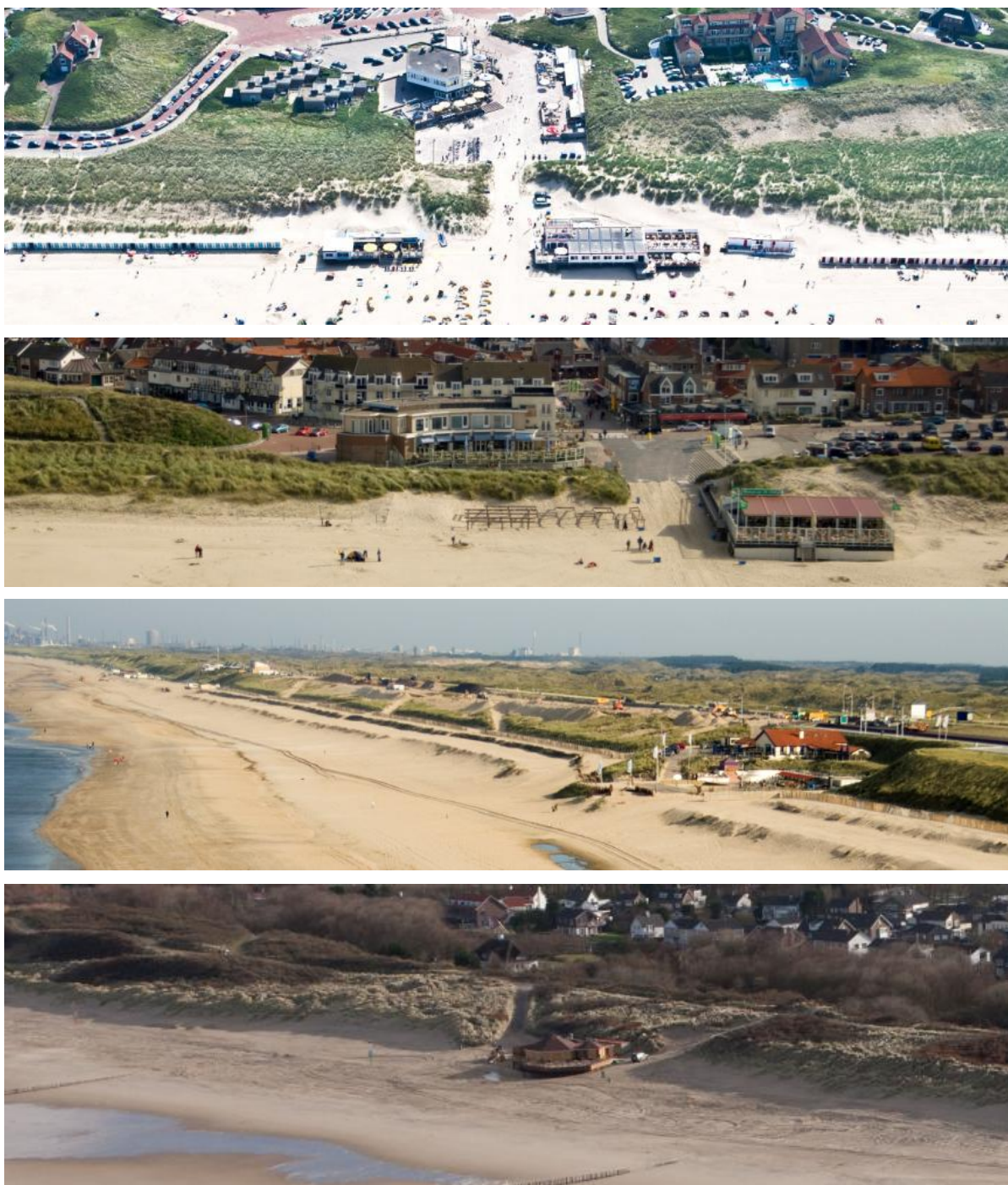
Foto 4.2. Lagere duinwaterkeringen ter hoogte van enkele kustplaatsen (van boven naar beneden: Bergen aan Zee, Egmond aan Zee, Zandvoort, Cadzand. Beeldbank Rijkswaterstaat 2005).
