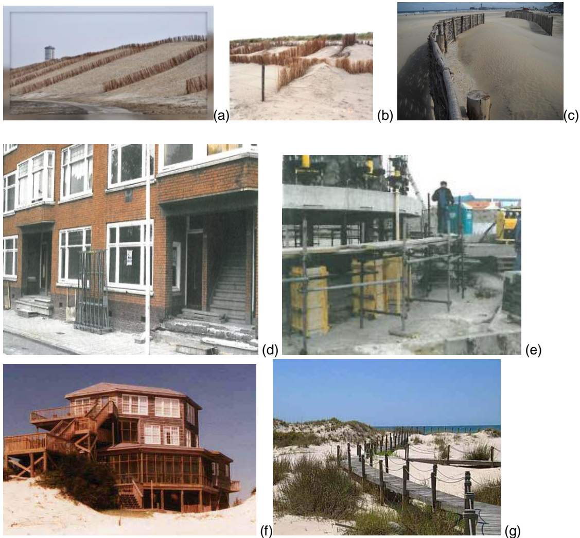
Foto 4.1. Het concept duin zand-op-duin betreft duinaanwas door duinversterking, dan wel het bevorderen van natuurlijke duinaanwas in combinatie met aanpassingen aan bebouwing door het opvijzelen of bouwen op palen. Foto's:
