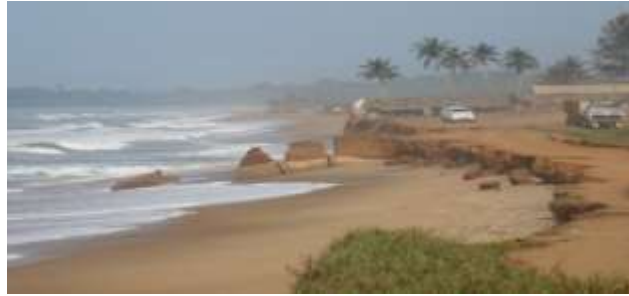
Figure 16. Erosion à San-Pedro.
