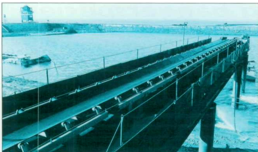
Transportband overlslag vervuilde specie.
