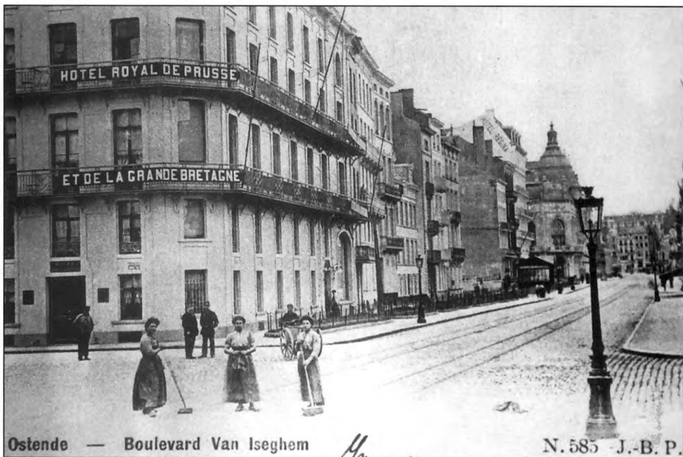
De Van Iseghemlaan met op de achtergrond het chalet dat de ingang vormt tot het ondergronds aquarium.
