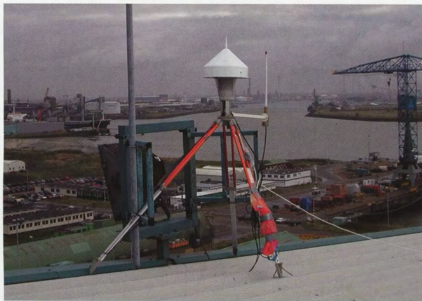
Foto van het base station op de driepoot
