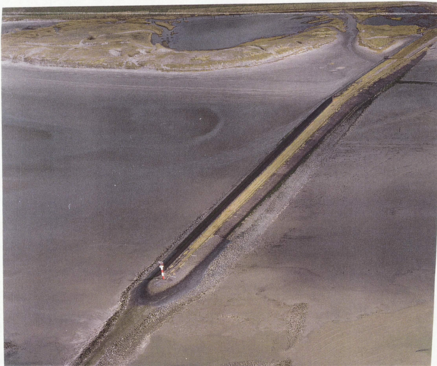
Location 'Slufter bij Kaloot' (Photo RWS, Meetkundige Dienst Afdeling Grafische Technieken).
