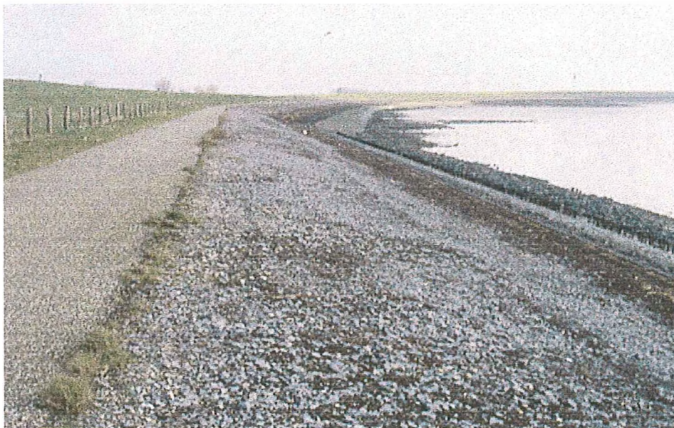
Zeedijk Borsselepolder oost, Zuid-Beveland, 13 februari 2001. Dijkbekledingswerken uitgevoerd in 1997, en na vier jaar nog steeds aantrekkelijke broedplaats voor Bontbekplevieren: kale of spaarzaam begroeide glooiing met veel steenslag. Verharde onderhoudsweg. (foto Peter L. Meininger)
