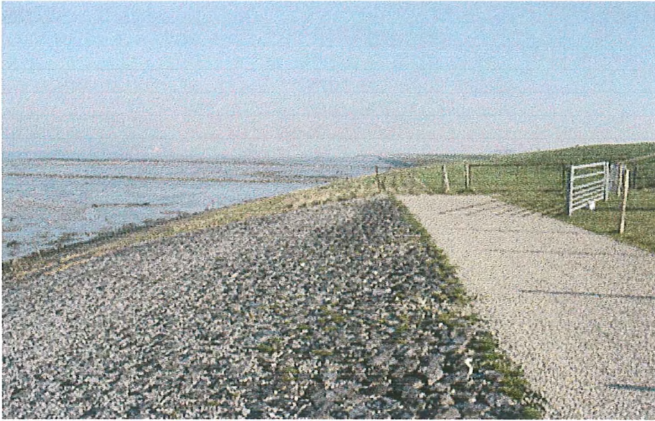
Zeedijk Perkpolder, overgang naar Molenpolder, Zeeuwsch Vlaanderen, 15 februari 2001. Oorspronkelijke zeedijk met begroeid talud, ongeschikt voor broedende plevieren, en onverharde onderhoudstrook; nieuw beklede zeedijk met aantrekkelijke broedplaats voor plevieren en verharde onderhoudsweg (foto Peter L. Meininger)
