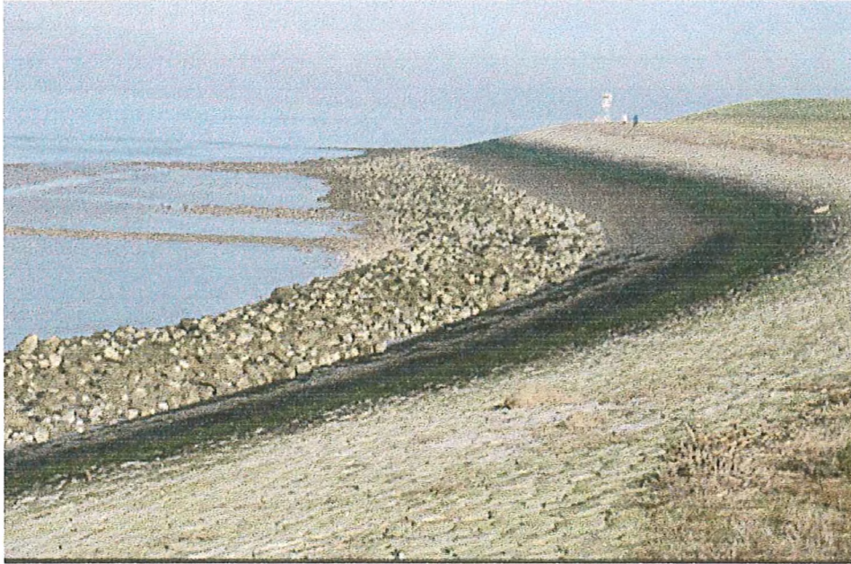
Zeedijk Kleine Huissenspolder, Zeewuwsch Vlaanderen, 15 februari 2001. Nieuw beklede zeedijk (uitgevoerd 1997): ondanks geringe hoeveelheid steenslag toch gebruikt als broedplaats door Strandplevier. Er is een brede overlaging aangebracht, die een barrière vormt voor jonge plevieren tussen dijk en slik ( foto Peter L. Meininger )
