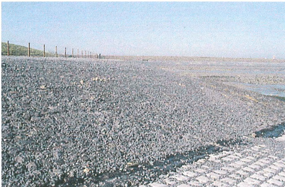
Zeedijk Thomaespolder, Zeewuwsch Vlaanderen, 15 februari 2001. Nieuw beklede zeedijk (uitgevoerd 2000): veel steenslag, geen begroeiing, grenzend aan slik: potentiële broedplaats voor plevieren! ( foto Peter L. Meininger )
