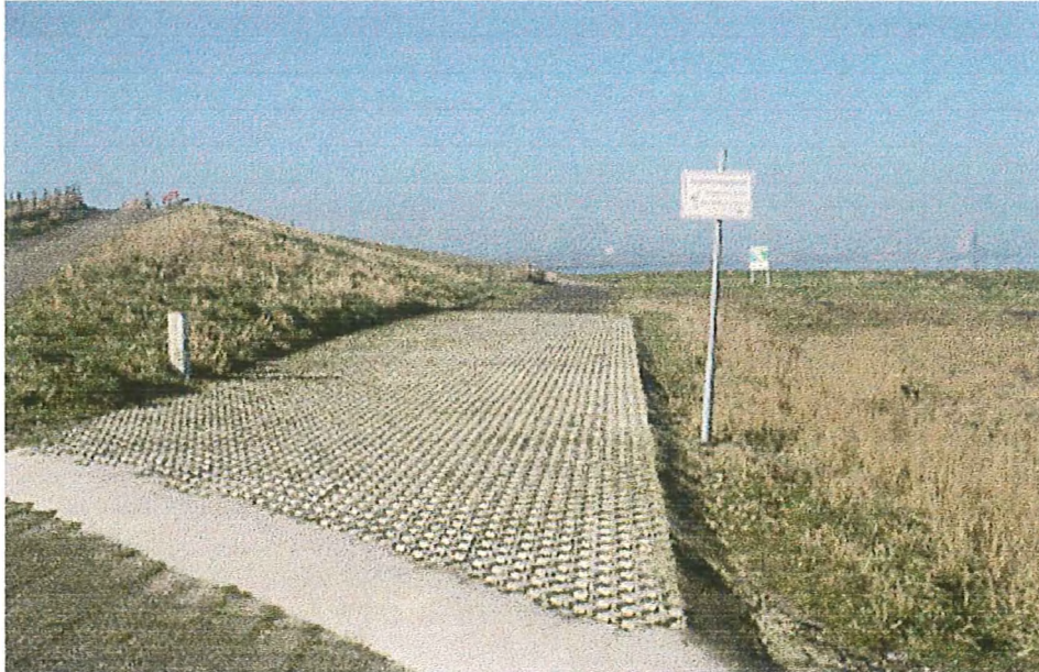
Fietsbarrière op de zeedijk bij Nummer Een, Zeeuwsch Vlaanderen, 15 februari 2001. Enkele tientallen meters lopen weerhoudt slechts weinig fietsers! (foto Peter L. Meininger)
