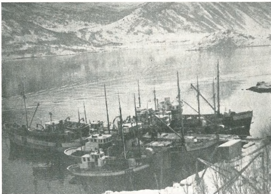
Fig. 22. Båter under montering av hydrauliske vinsjer ved HYDRAULIK A/S's kai i Brattvåg.
