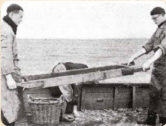
Fig. 3 De krabben- en garnalenzeef, voor het manueel sorteren van de vangst en het scheiden van de garnalen van de bijvangst (Foto's: Hovart et al., 1960).
