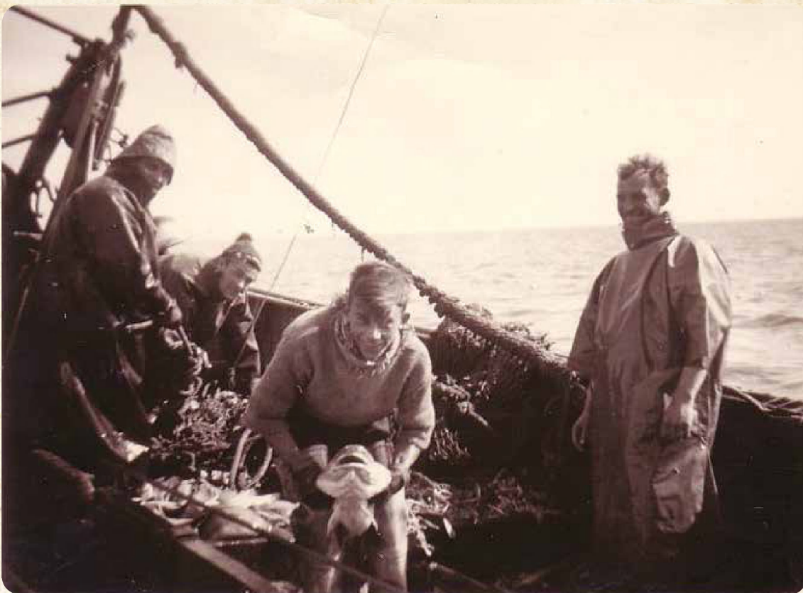
Fig. 6 Aan boord van een plankenvisser wordt het net met mankracht binnengehaald. De planken zijn de scheerborden die dienen om het net open te houden (Foto: Sincfala Beeldbank, VLIZ Fotogalerij).
