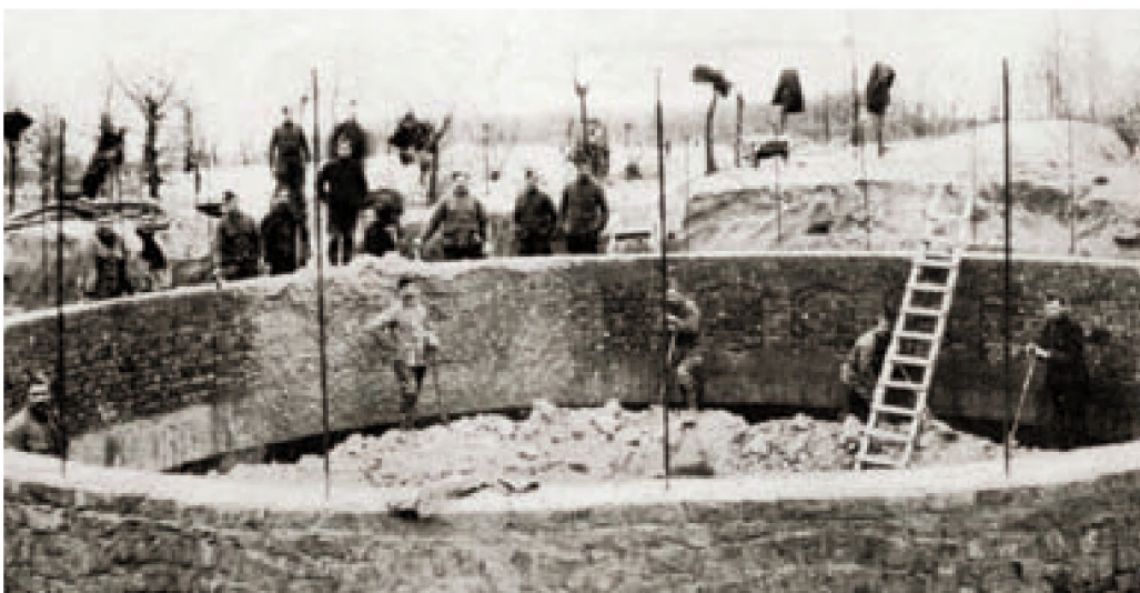
■ De bouw van de collectorput in de winter van 1917-1918 (Archief Walter Lelièvre, Ramskapelle)
