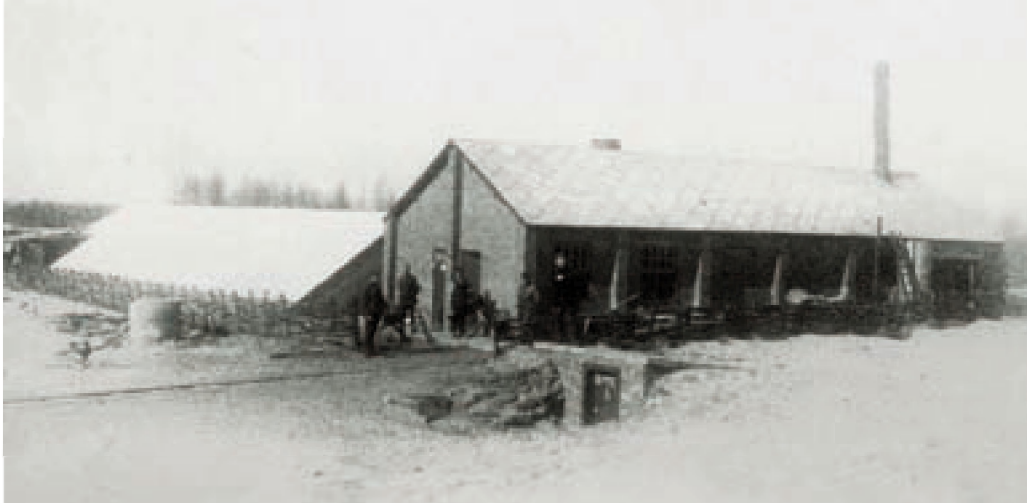
■ Het pompgebouw van de waterwinning in de duinen van Cabour, winter 1917-1918 (Archief Walter Lelièvre, Ramskapelle)
