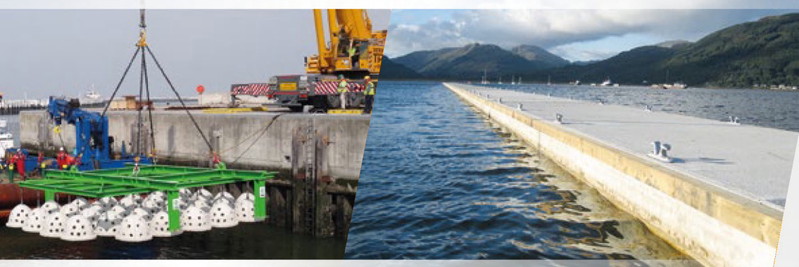
▲ Een drijvende golfbreker werd op 24 uur geïnstalleerd te Holy Loch, Scotland Foto: Intermarine Limited
