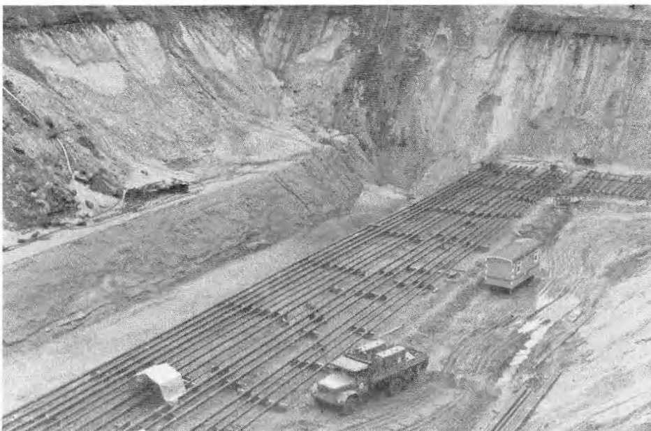
FIG. 4 Omlegging van nutsleidingen en industriële leidingen.
