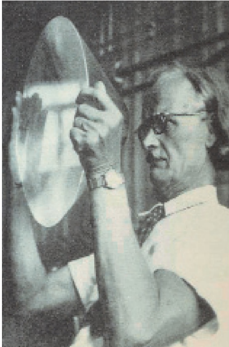
■ Piccard's ontwerp van conische vensters, die met toenemende druk voor een zelfdichting van de voegen zorgen, is overgenomen in alle latere diepzeeduikboten, net zoals vele van zijn uitvindingen (historische bron)
