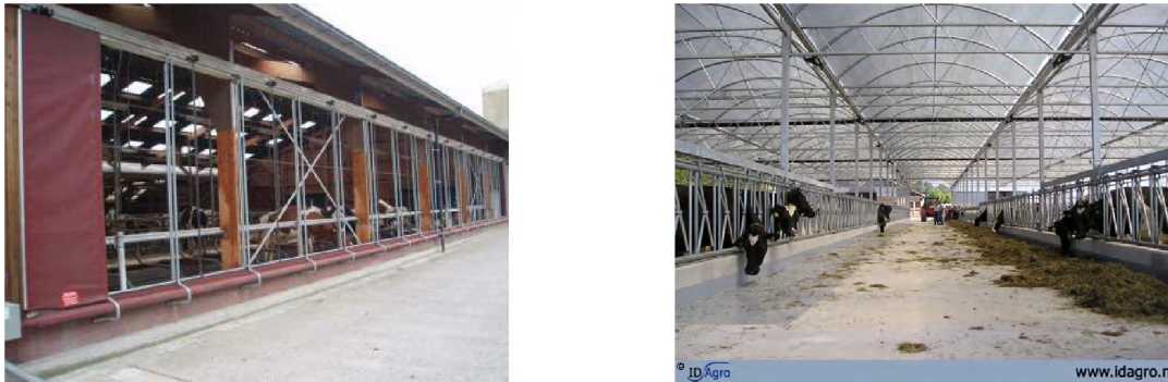
Figuur 19 Links: melkveestal met open zijwand (© bvba Vervaeke); Rechts: serrestal voor melkvee (© ID Agro)
