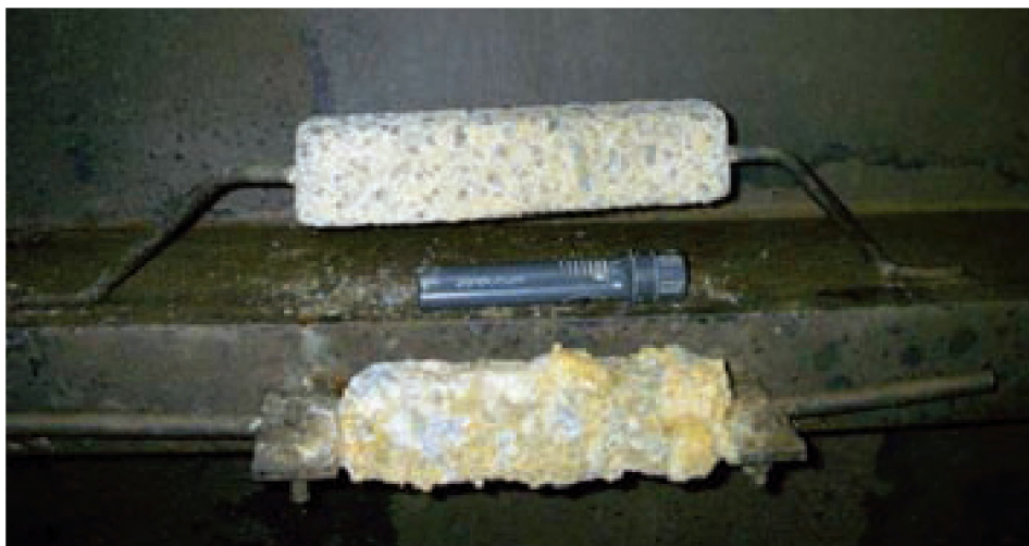
■ Door in de ballasttanks op regelmatige en goed gekozen plaatsen blokken minder edel metaal (bv. zink of aluminium) of "opofferingsanodes" aan te brengen en die elektrisch te verbinden met de te beschermen wanden, wordt corrosie afgeremd (HZS)
