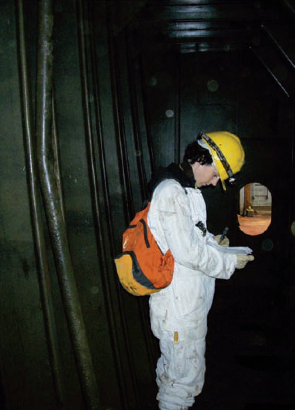
■ Zicht op een moderne ballasttank, ter illustratie van de vaak moeilijke toegankelijkheid en de complexe opbouw. De openingen meten ongeveer 70 bij 100 cm (HZS)
