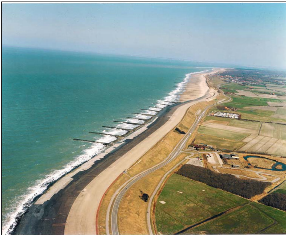
De Westkappelle Zeedijk is één van de kustvakken die al op korte termijn versterkt moet worden.
