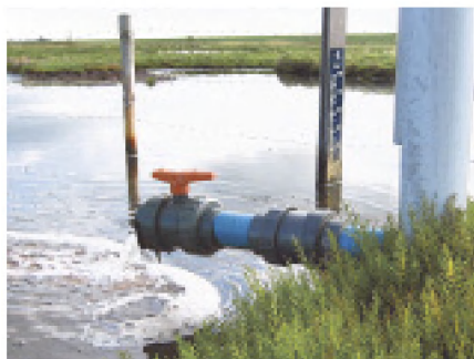
Via een kwelbuis wordt de kwelstroom in het natuurgebied versterkt
