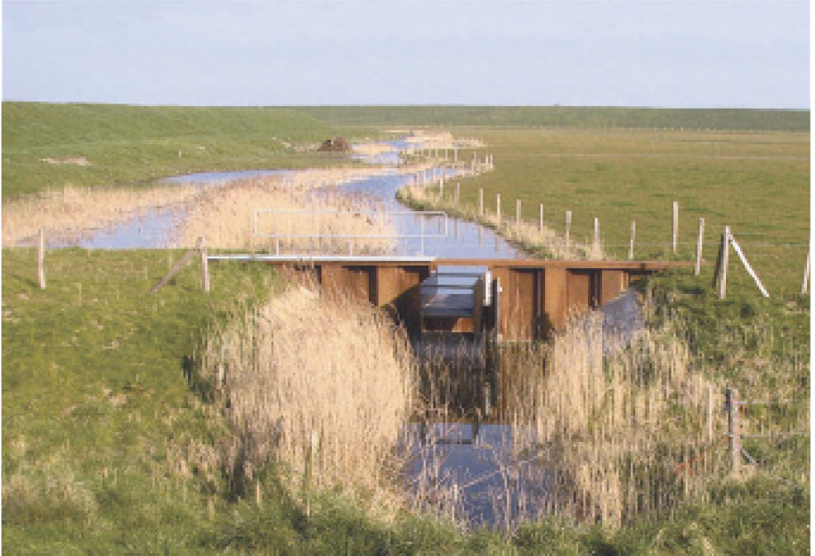
Regelen van de waterhuishouding met een stuw
