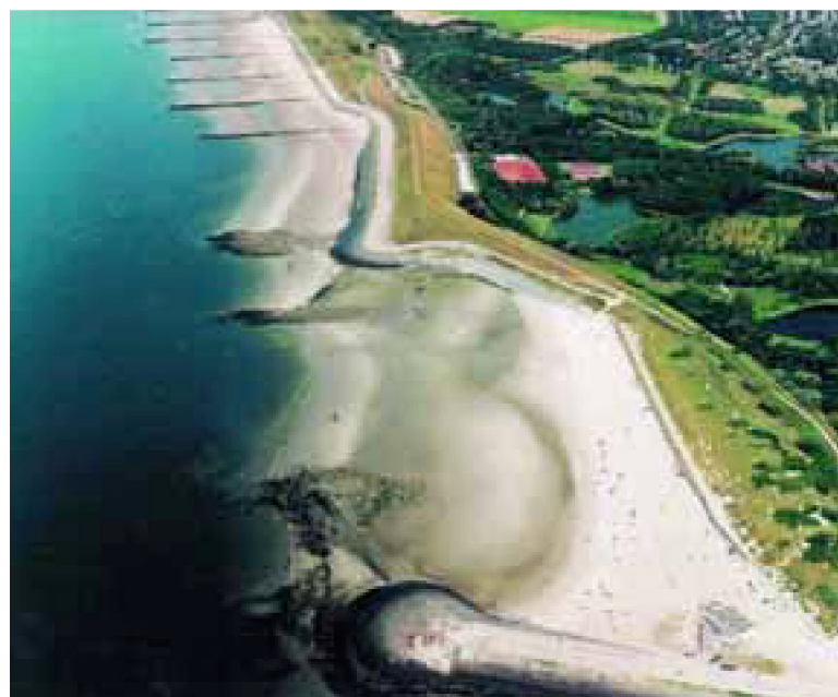
De Nolledijk bij Vlissingen is ook een van de acute zwakke schakels.
