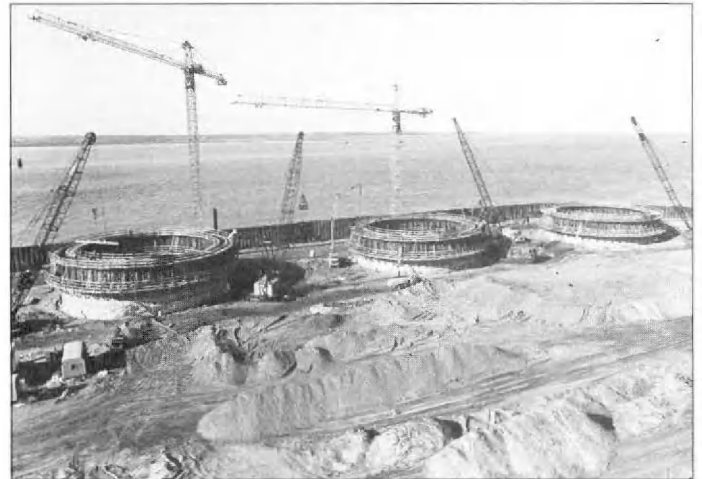
Foto 6: inwendige ontgraving binnen in de caissons.
