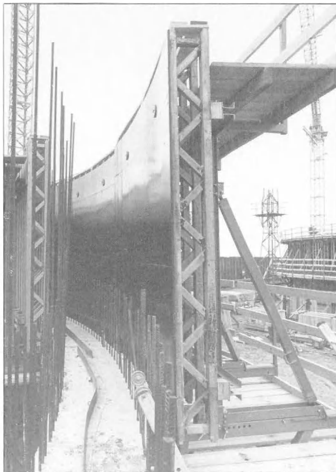
Foto 4: opbouw kleinbekisting.
