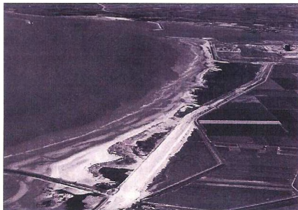
Afb. 2 Aanleg van het oostelijke dijktraject vanaf de Noordnol tot het middendeel door de oude duinontwikkeling bij de slufter (De Westerschelde erfdeel van het Zeeuwse Landschap 1967)
