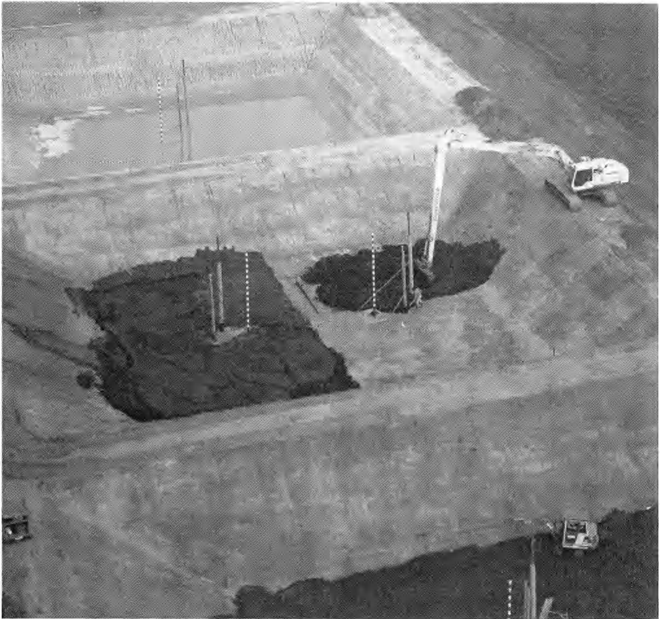
Fig. 4. — Tewerkstellen van het ontwaterd slib in proefveld DIV. [bij 5.2.2, foto 280 990 - 703]
