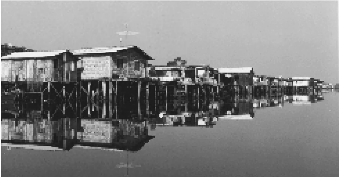
Figuur 2-4 Paalwoningen in Brazilië
