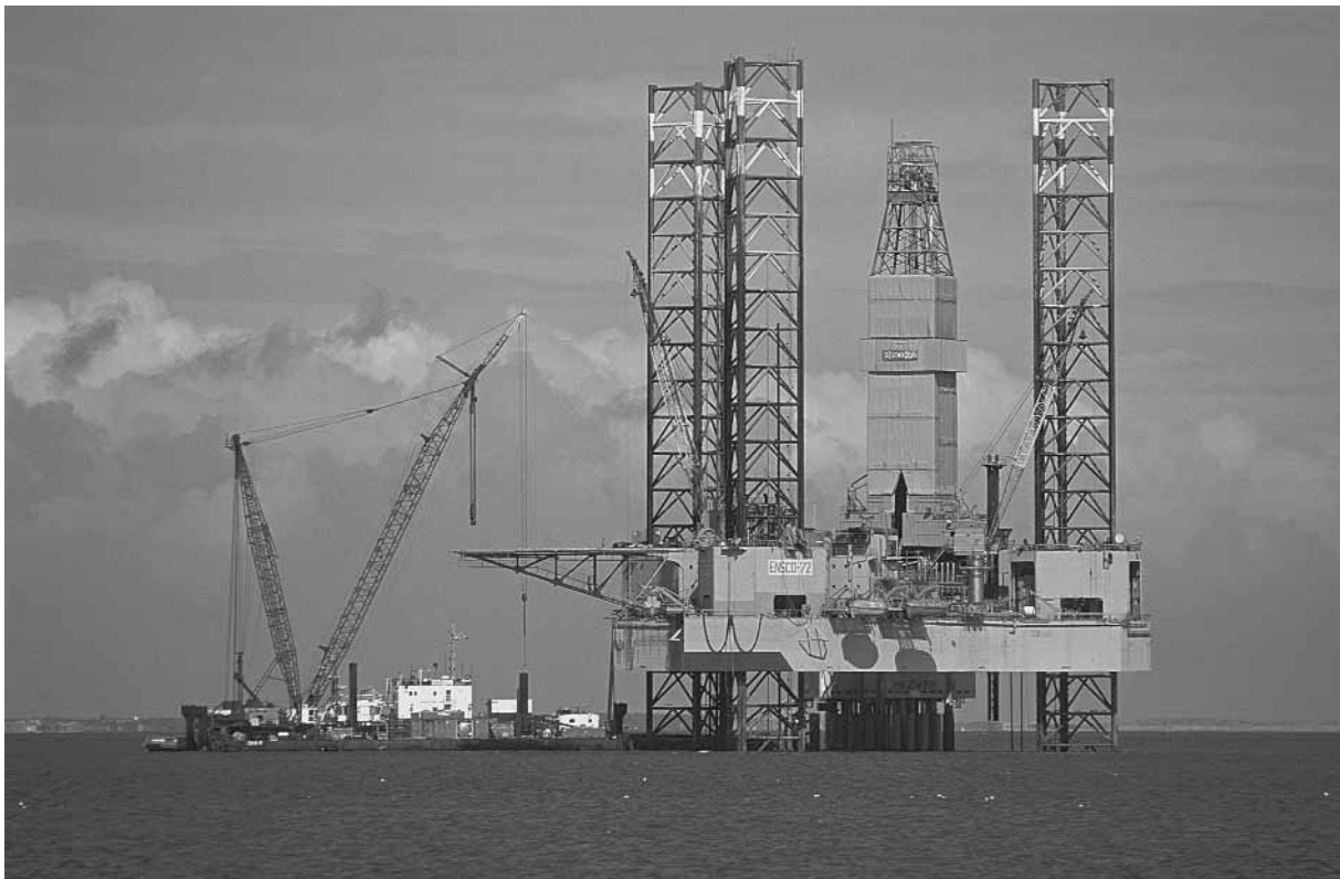
Boortoren bij Zuidwal, westelijke Waddenzee. De geplande gaswinning zal vanaf het vaste land gebeuren.
