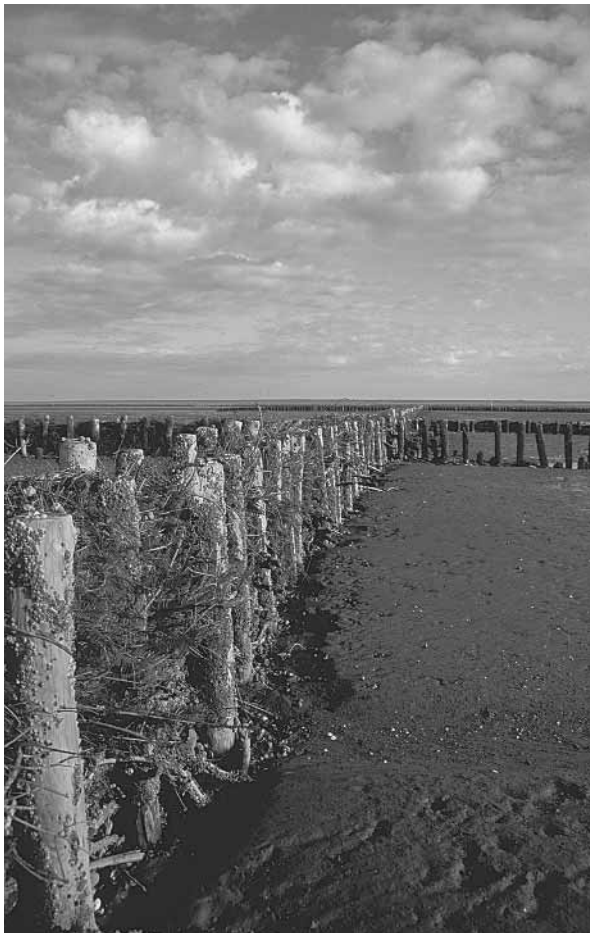
Landaanwinningswerken in Sleeswijk-Holstein; een manier van kustverdediging.
