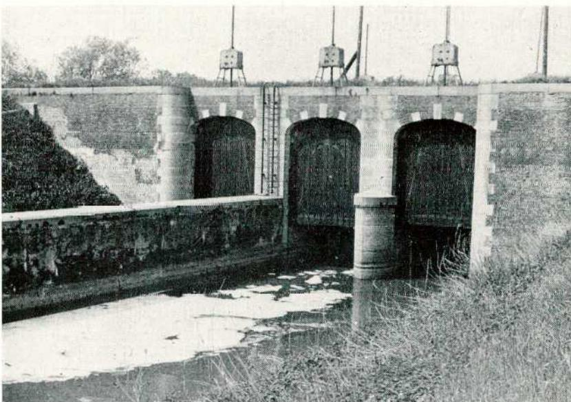
Photo 3. — Débouchés du Zielbeek et de l'Appeldonkbeek dans le Vliet: les écluses à marée.
