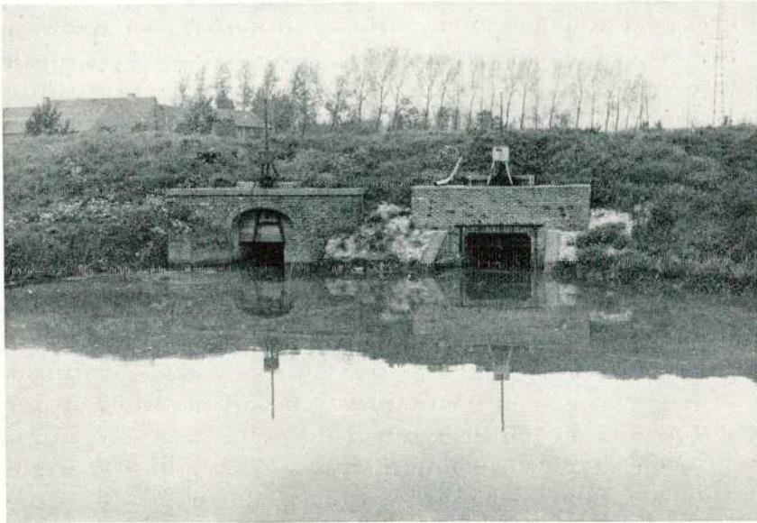
Photo 4. — Débouché du Molenbeek dans le Vliet à Puurs. Eclusettes à marée.
