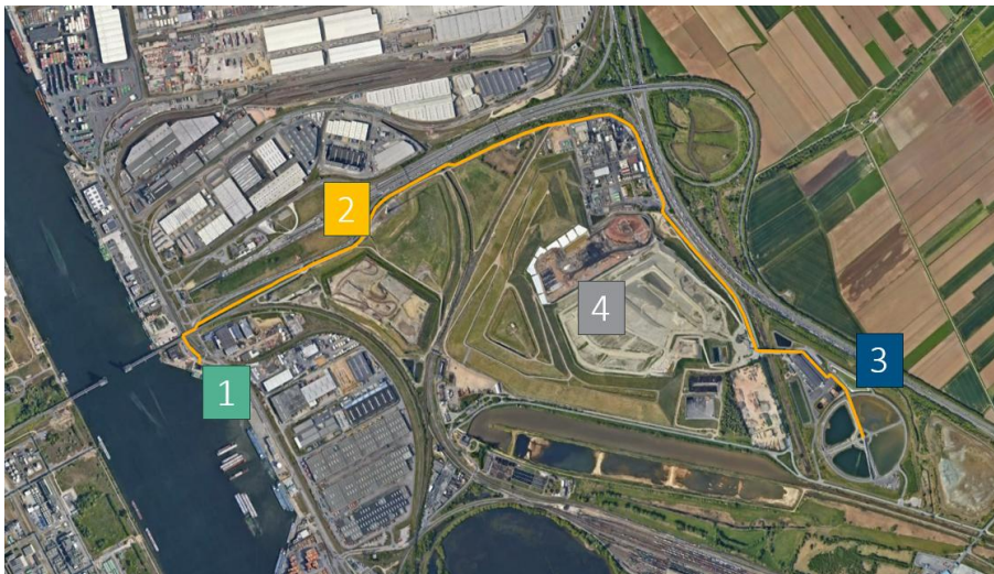
Figuur 1: AMORAS installatie voor mechanische ontwatering van sediment: 1) Onderwatercel en zandscheider, 2) transportleidingen, 3) ontwateringsinstallatie en waterzuivering, 4) stockage sedimentkoeken.
