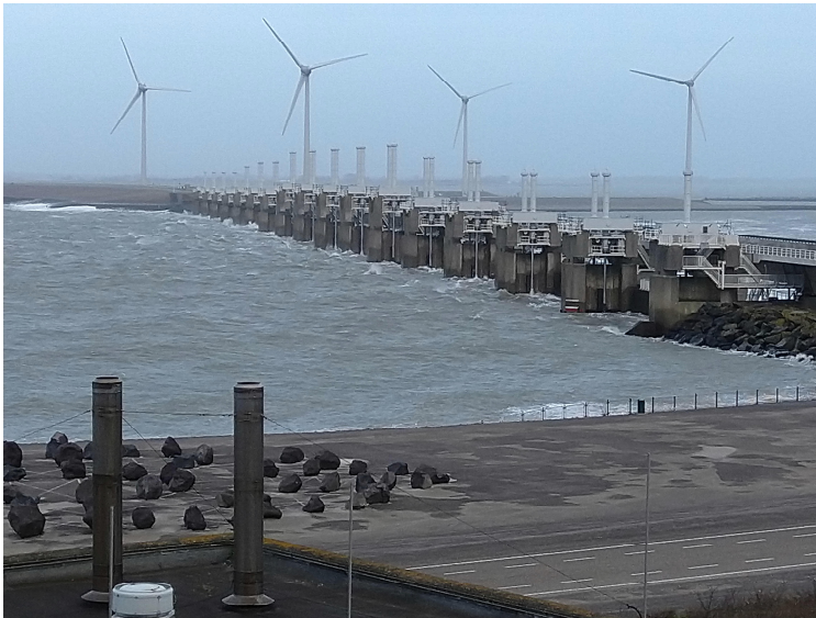
Figuur 14: Oosterscheldekering in gesloten toestand
