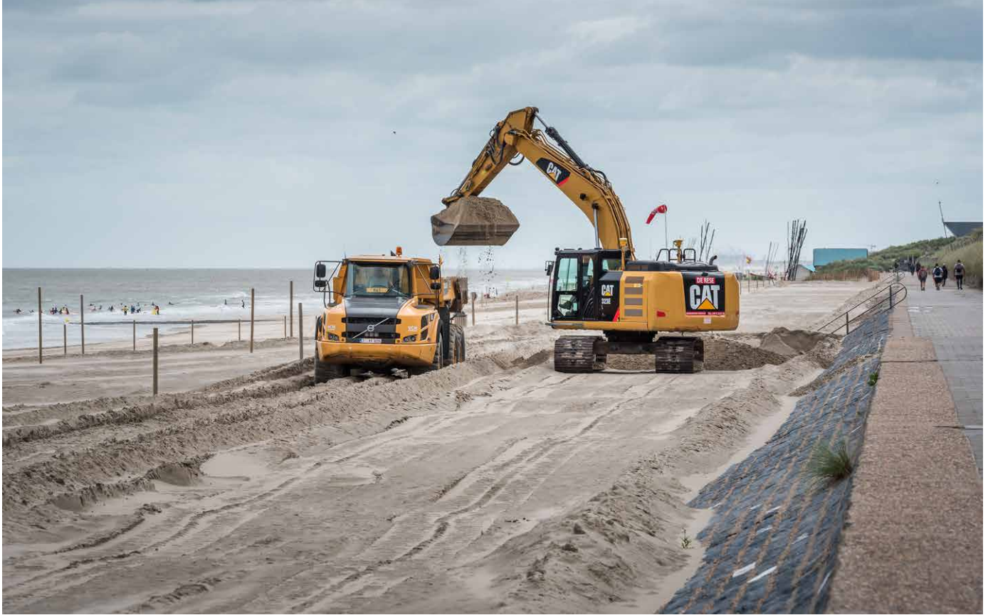
Strandwerken met bulldozers en graafkranen (© Glenn Strypsteen)
