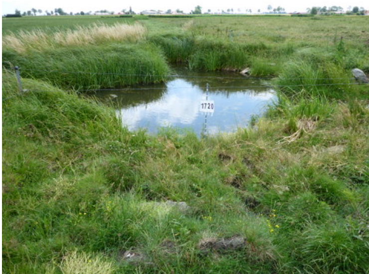
Fig. 2 – Voorbeeld van een niet meer functionele “wedding” aan het uiteinde van segment 1720, uitmondend in een treksloot.
