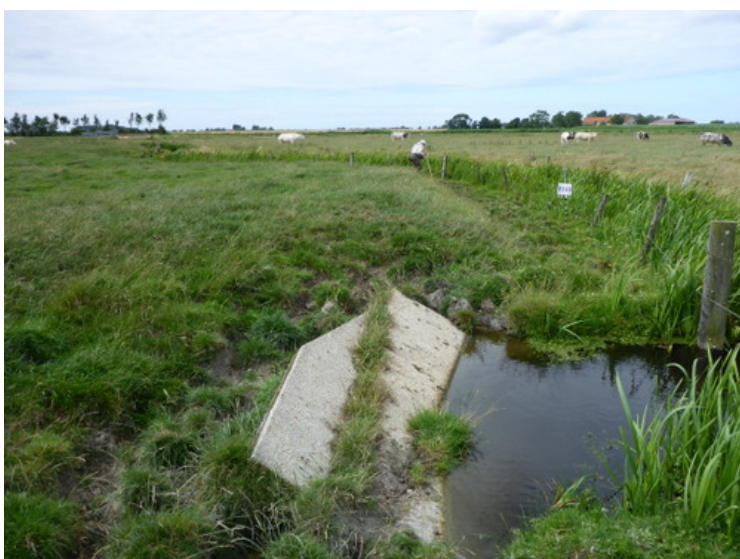
Fig. 3 - Een wat opgelapte, maar voor het vee niet echt geslaagde, vorm van “wedding”.
