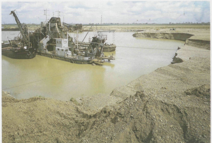
Grindbaggervaartuigen aan het werk langs de Maaskant, Aldeneik
