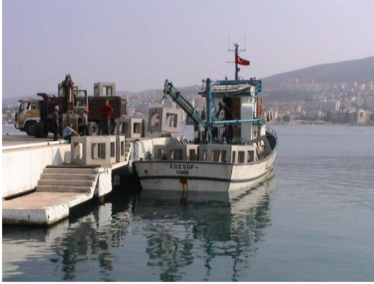
Şekil 3. Yapay resif bloklarının taşınması ve suya bırakılması
