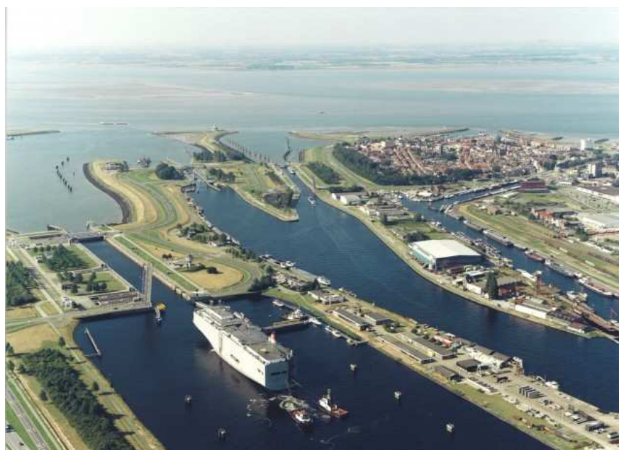
Figuur 2.2: Sluisencomplex Terneuzen
