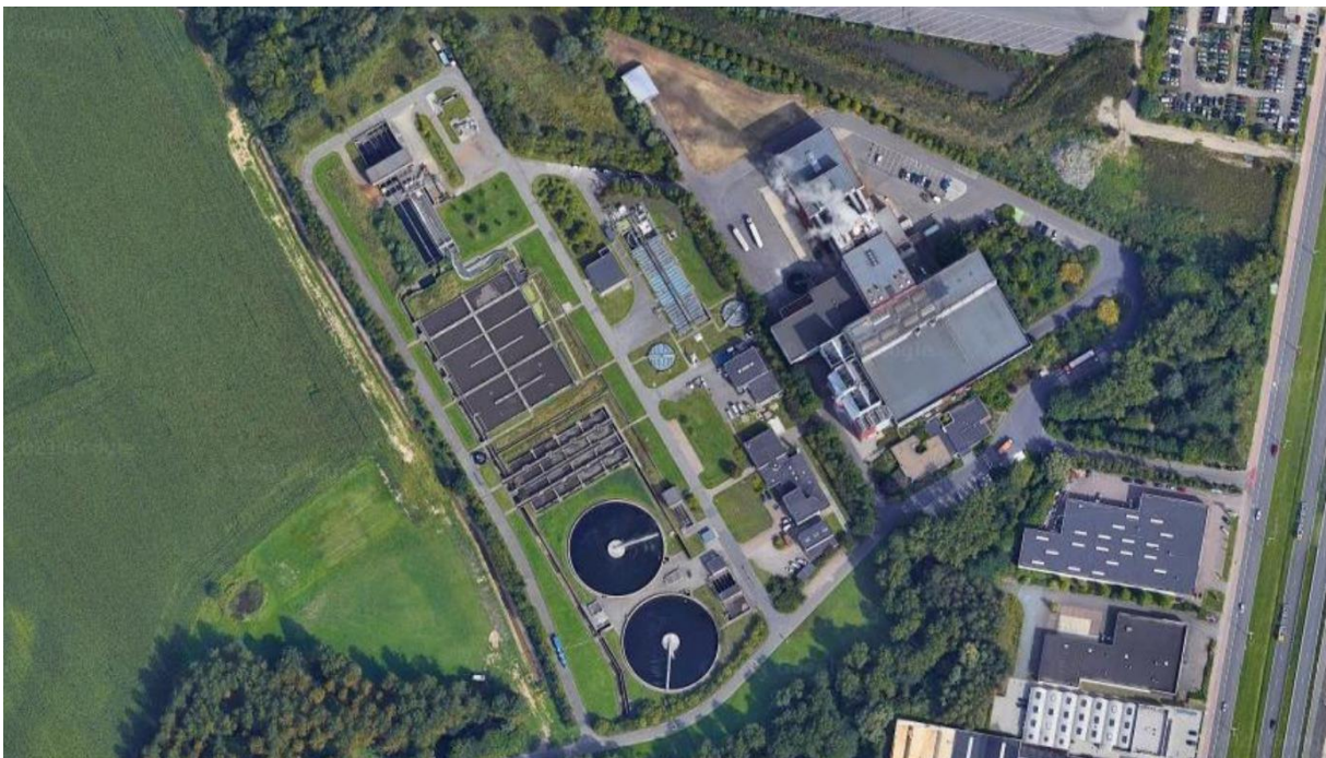
Figuur 2: Overzicht rioolwaterzuiveringsinstallatie in Aartselaar
