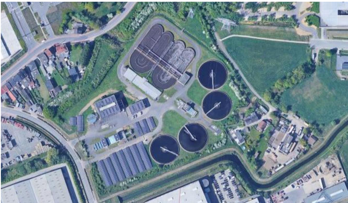
Figuur 9: Overzicht rioolwaterzuiveringsinstallatie in Grimbergen
