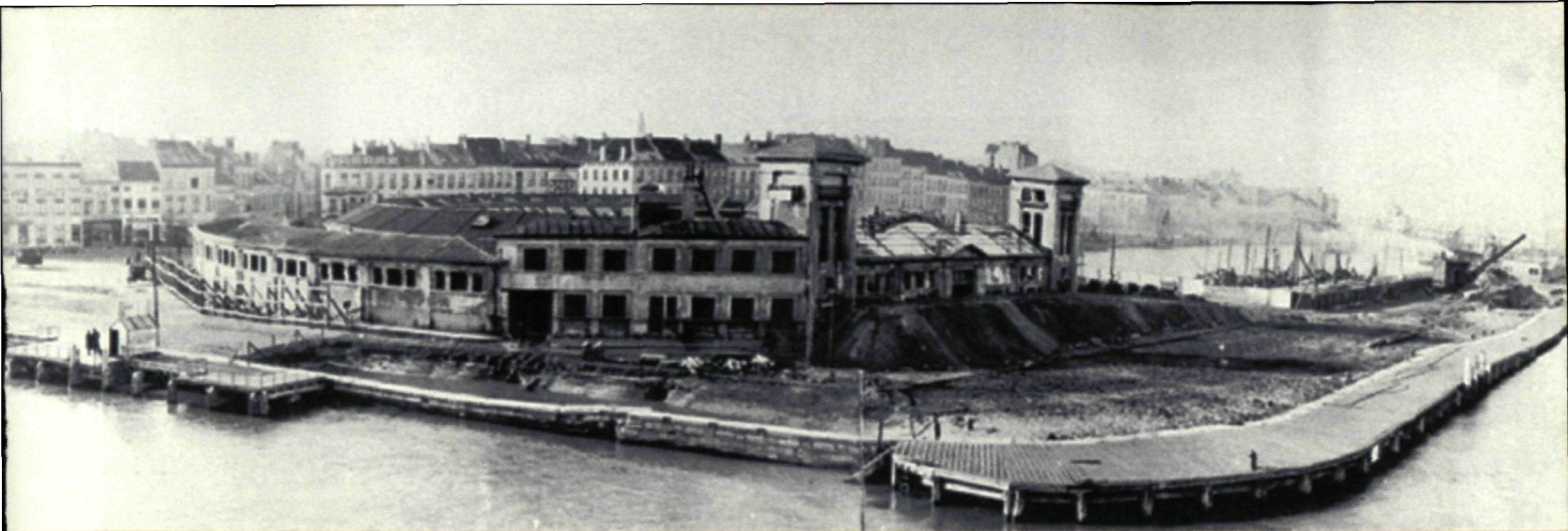
In 1938 werd de vismijn in de stad (de zgn. cierk) afgebroken. Aan het begin van de afbraakwerken liet de aannemer nog een foto van het gebouw maken. Wijlen Frank Redant wist de foto in zijn collectie onder te brengen.
