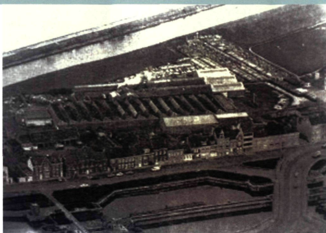
Luchtfoto van de sprotfabriek Ostendia te Bredene. Boven de fabriekshal is de 15-kappige dakconstructie te zien. Naast de fabriekshal zijn er ook nog magazijnen voor ledige en volle blikken en de blikslagerij.
