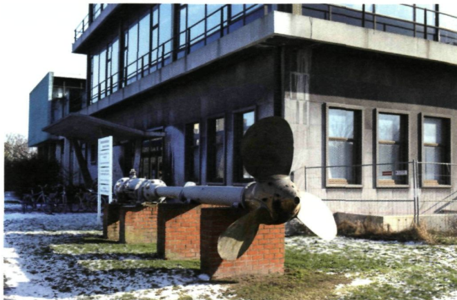
In de Mercatorlaan 15 bevindt zich de voormalige Stedelijke Visserijschool 'John Bauwens', thans 'Provinciaal Maritiem Instituut'. Het gebouw verving de Stedelijke Visserijschool van 1886 in de Sint-Franciscusstraat, die ca. 1930 ondergebracht werd naar de Schippersstraat. In 1995 fuseerden drie visserijscholen, o.m. de vroegere John Bauwensschool en de Vrije Visserijschool 'paster Pype'. foto JoC
