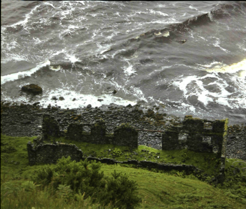
Op het wondermooie Isle of Skye: ruïne van een ... dynamietfabriekje. Ooit waren er experimenten om met dynamietstaven te vissen!
