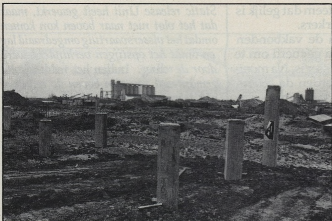
De paalfunderingen voor het European Fish Center in de Zeebrugse achterhaven zitten in de grond. Weldra wordt gestart met de opbouw van het betonskelet en het plaatsen van de wand- en dakpanelen. De nieuwe veiling moet klaar zijn tegen eind oktober om er de reeds aangekondigde visserijbeurs van 22 tot 25 oktober te laten doorgaan.
