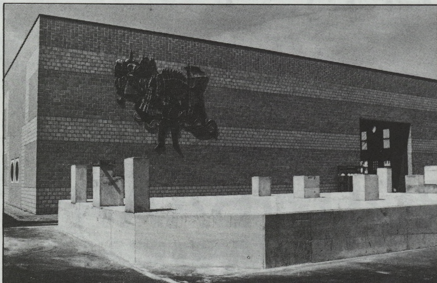
Naast de nieuwe vleugel van de Zeebrugse vismijn staat de basis voor de ijsproduktie-eenheid reeds klaar. Deze maand wordt de installatie gebouwd. (foto gw)
