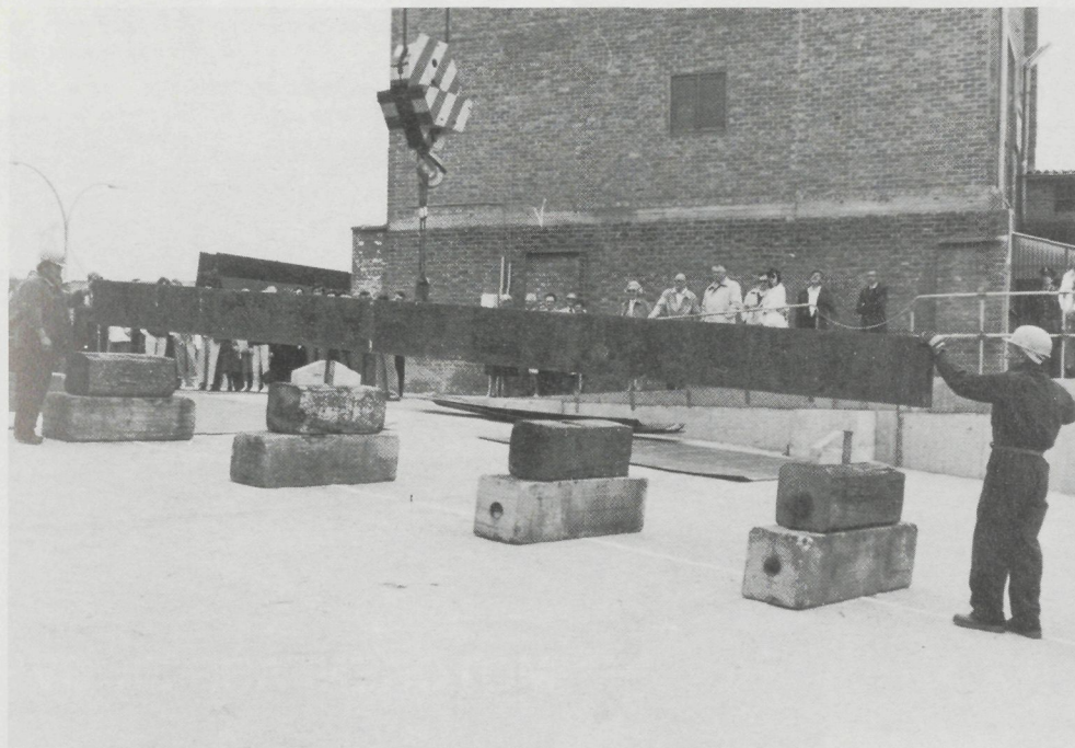
De symbolische kiellegging van de O.333 „Marco”, de eerste treiler die integraal door S.C.A.P. zal gebouwd worden. Op de stalen poutrel komt straks een 36 meter lange treiler te staan.
