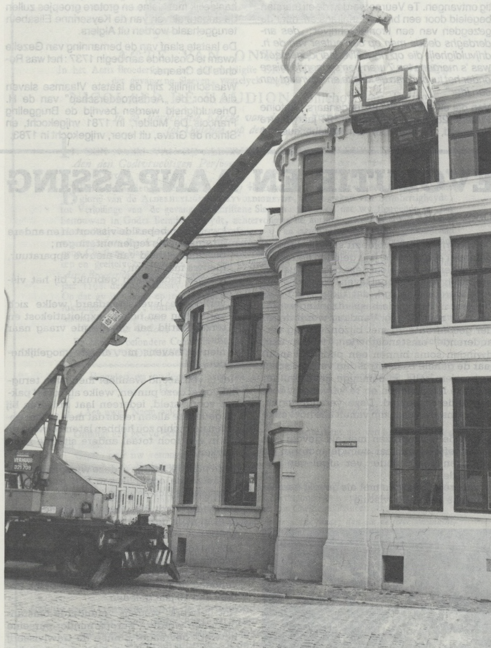
De Bolle is dringend toe aan belangrijke herstellingen en verbouwingen. - De Bolle bruist van activiteiten, dynamiek en vernieuwing.
