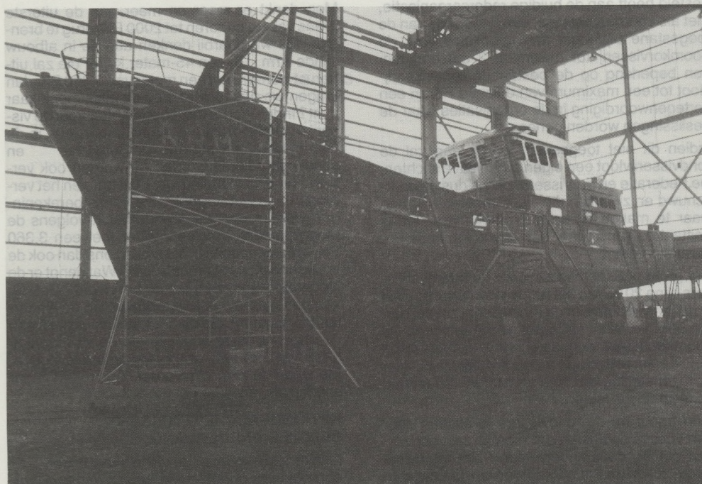
Zelfde kotter bij de verdere afbouw nadat het vaartuig terug op het droge werd gezet. De „ARM.18” is hier reeds voorzien van de brug.
