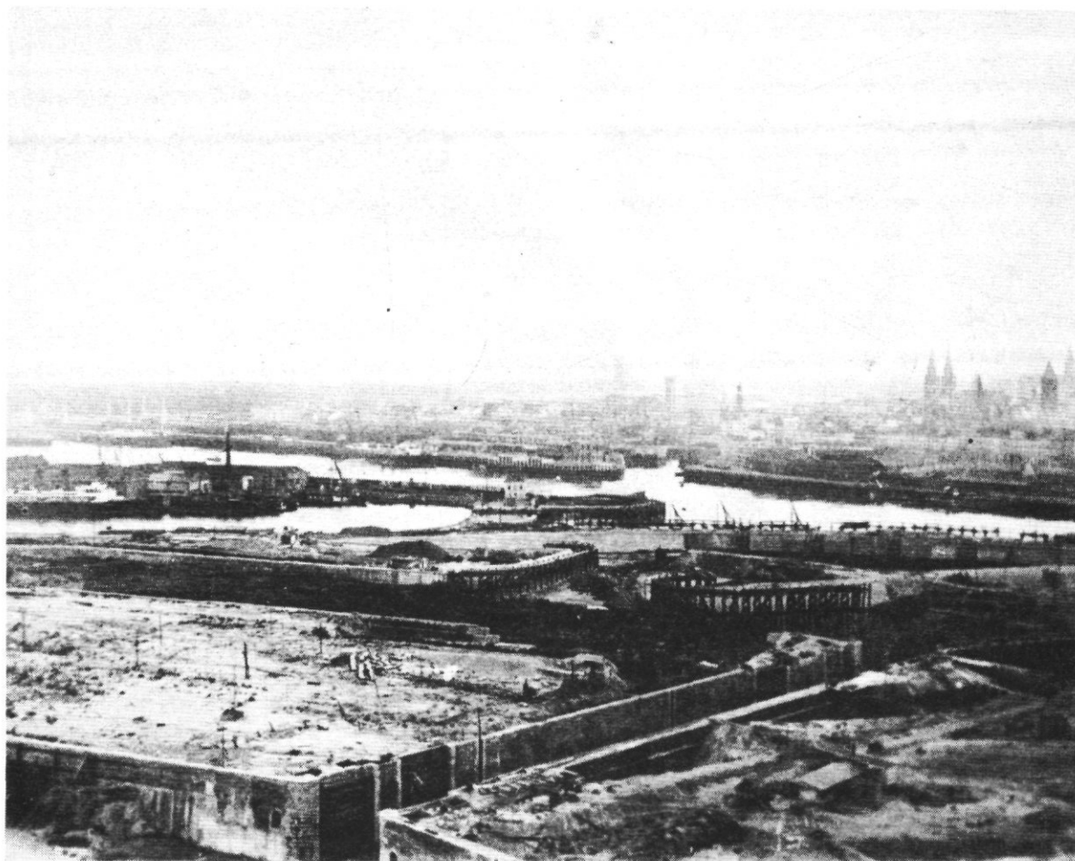
Fig.2.- 1926 - Bouw van de toegangssluis. Deze werd naderhand afgekeurd en vervangen door de huidige sluis.
