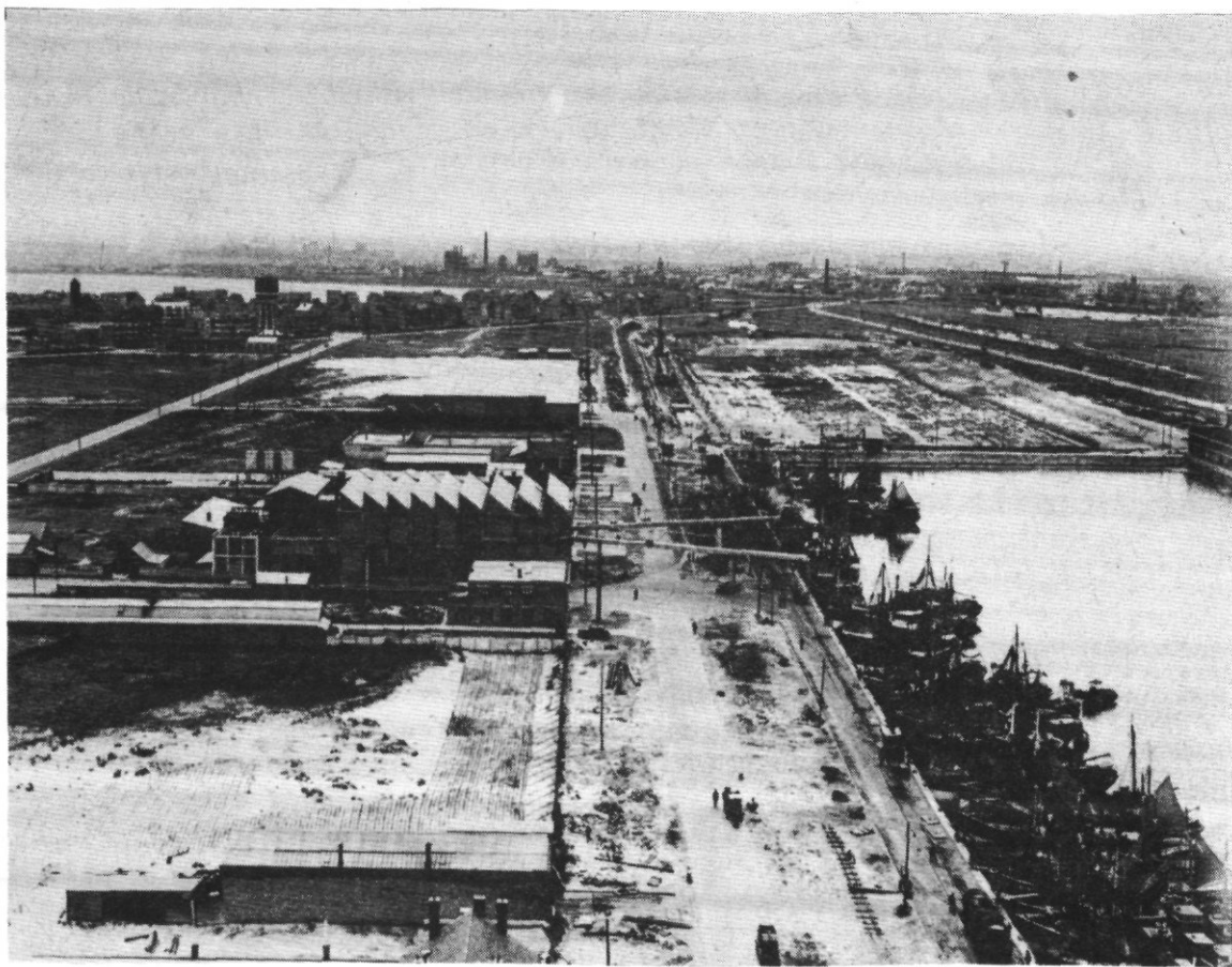
Zicht op de uitbreidingswerken genomen in juli 1937.
