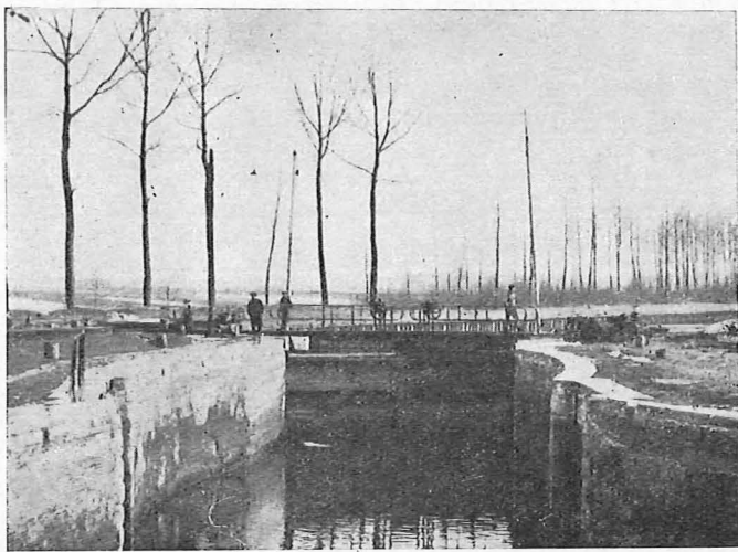
Het oude sas te Kampenhout in het kanaal van Leuven naar de Dijle.
