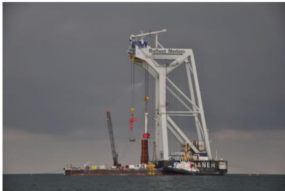
Figuur 2.68. Het heien van de funderingen van offshore windturbines genereert hoge onderwatergeluidsniveaus
