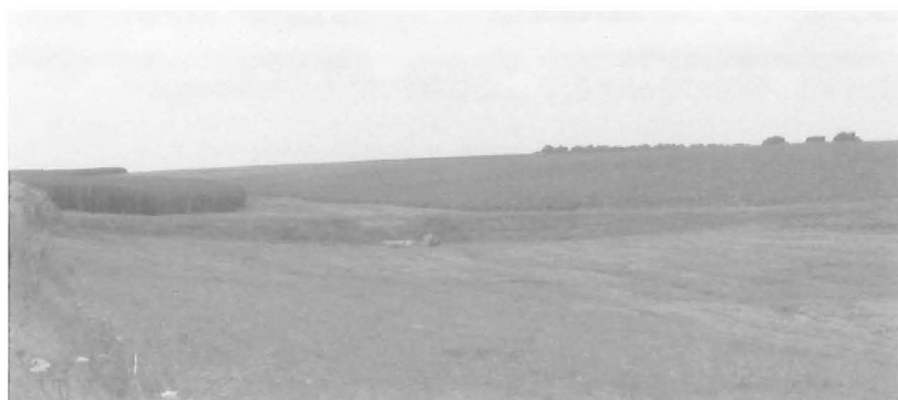
Foto 3 : Damconstructie in de Heulen Gracht.
